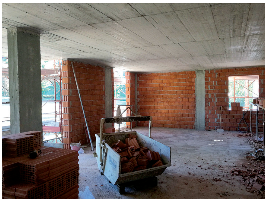
Fig. 8 - Realizzazione delle tamponature esterne in blocchi POROTON® 800 Klima Inc. 25, prodotti da Giussani Enrico & figli S.r.l.
